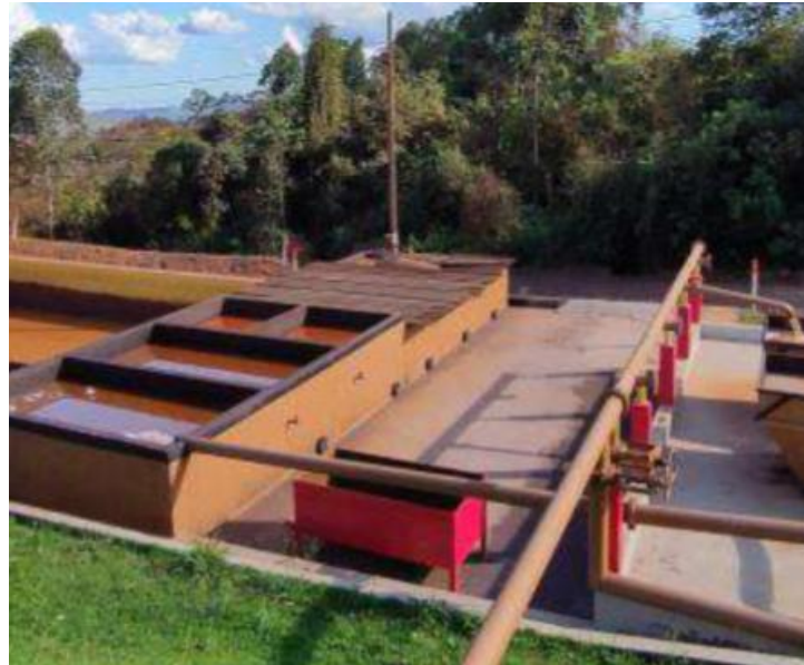
Figura 91 - Caixa separadora de água e óleo que trata os efluentes gerados nas áreas de manutenção.
