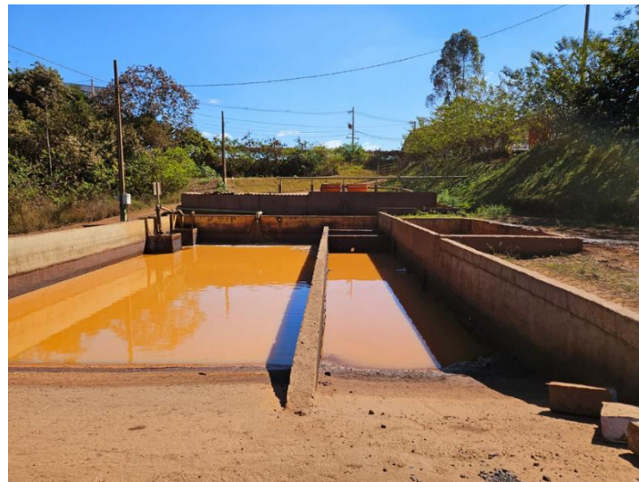
Figura 92 - Vista panorâmica da caixa separadora de água e óleo.
