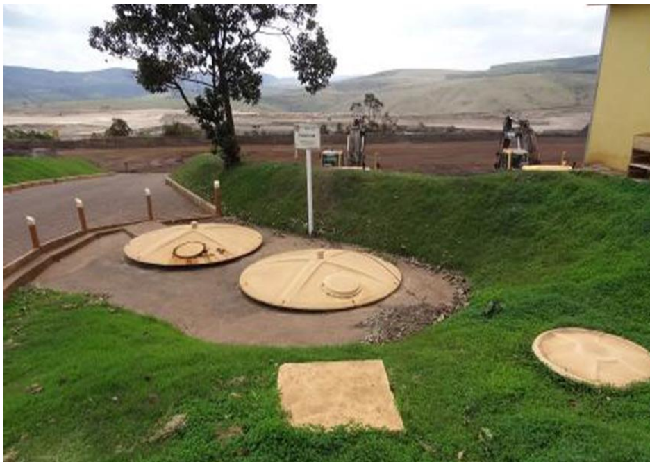
Figura 93 - Sistema de tratamento de efluentes sanitários constituído por fossa séptica - filtro anaeróbio, que trata as águas residuárias provenientes do refeitório.
