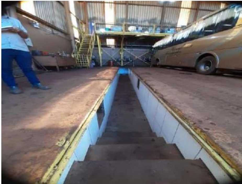
Figura 90 - Lavador de máquinas e veículos em área interna de manutenção.
